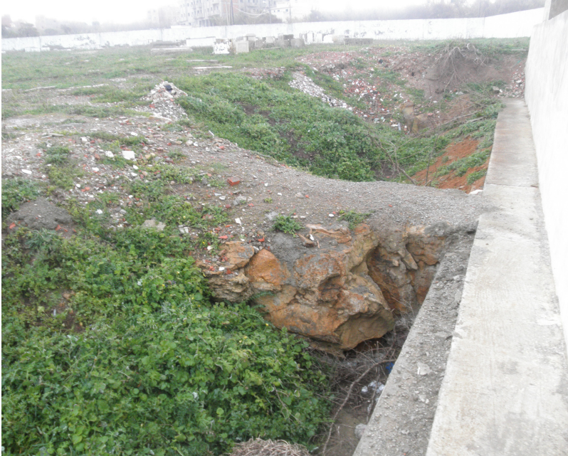
Reparaciones para evitar la erosión del mar en el cementerio judío de Arcila.
